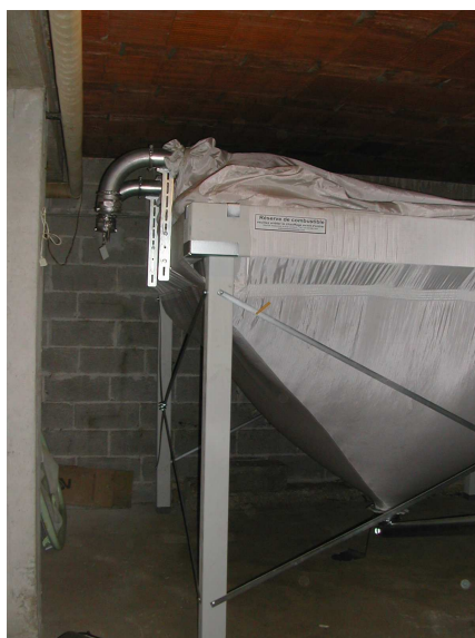
Détail du silo
